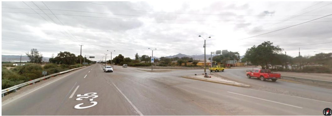
Imagen 13: Empalme flujo desde Tierra Amarilla con flujo cruce Paipote (DDA).
